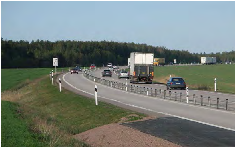
Figure 1 Une barrière centrale câblée installée sur une route en Suède
