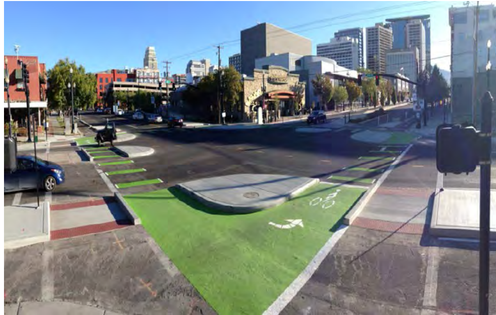
Figure 6 Une intersection protégée à Salt Lake City
